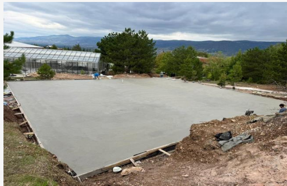
Meyve Kurutma Tesisİ İnşası
