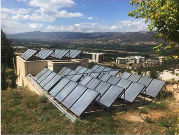
Güneş Enerjili Isıtma Panelleri
