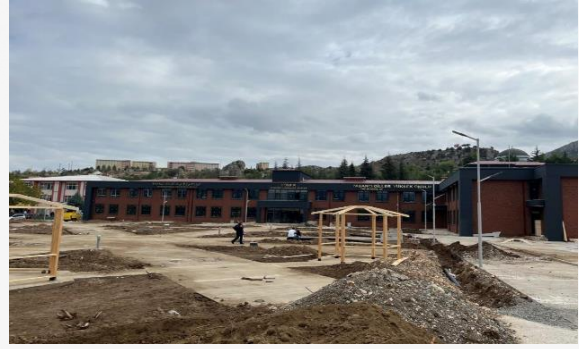
Tömer Binası Ve Peyzaj Projesi Uygulaması
