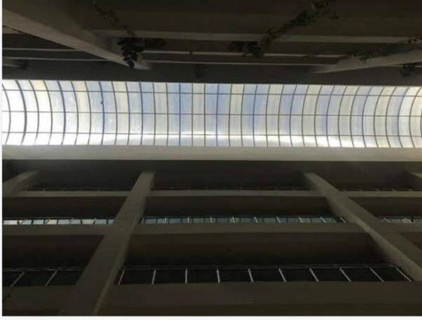
Doğal Aydınlatma Sağlayan Çatı Uygulamaları
