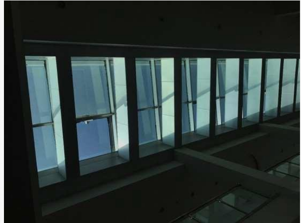
Doğal Havalandırma için Hareketli Çatı ve Pencere Uygulamaları
