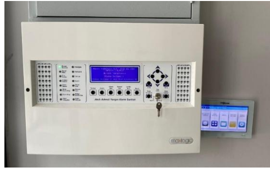
Merkezi klima santrali kontrol üniteleri ve yangın algılama santrali
