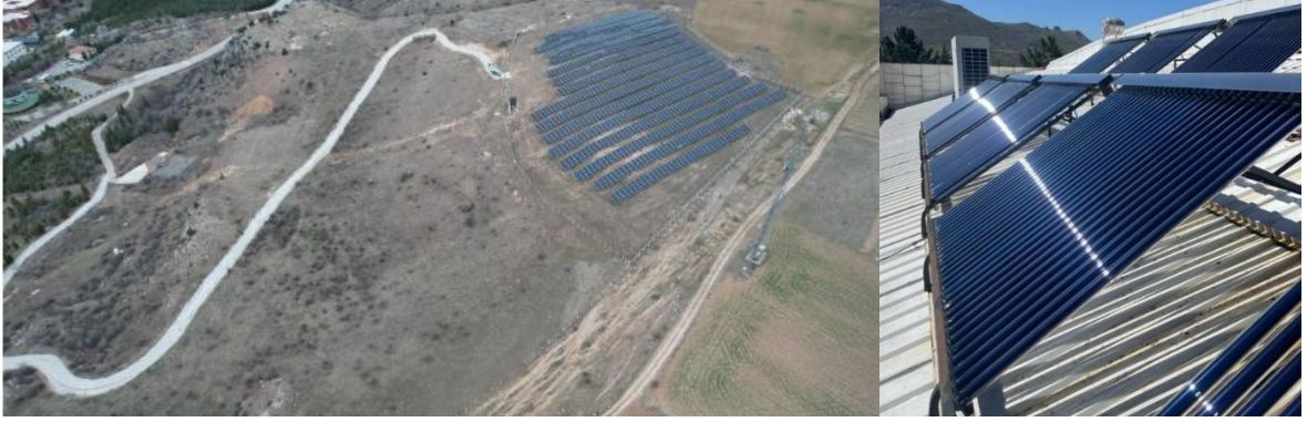
Güneş enerjisi santrali (solda) ve sıcak su üretimi için güneş kolektörleri (sağda)
