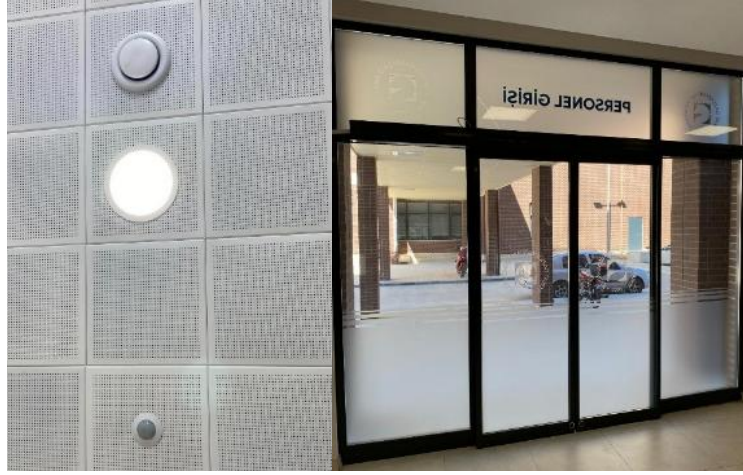
Fotoselli aydınlatma sensörleri ve otomatik fotoselli kayar kapılar
