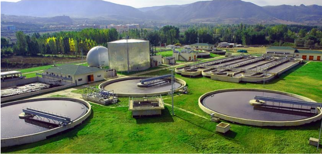
Tokat Belediyesi Atık Su Arıtma tesisi
