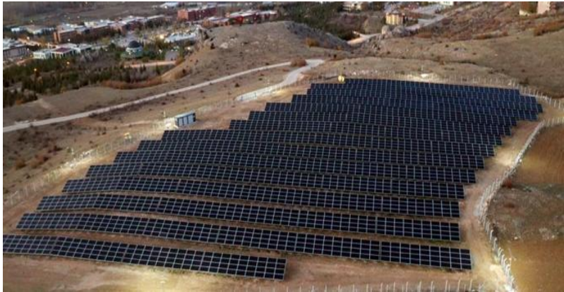
Kampüsteki mevcut ve yeni kurulan güneş enerjisi santralleri (GES)
